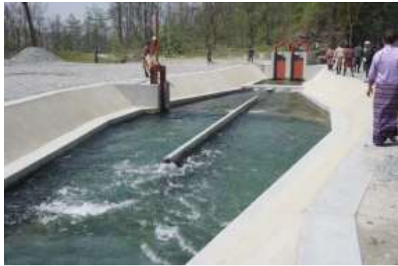
(完成した灌漑施設)
